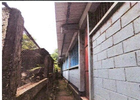
Foto 6: SE OBSERVA QUE HACE FALTA CANAL PARA AGUA.
