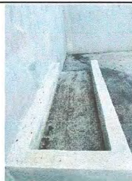
Foto 8: Se observa que la estufa artesanal no cuenta con plancha de metal.
