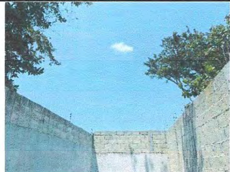
Foto 14: Se observa que la cocina no cuenta con sistema electrico
