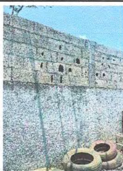
Foto 17: Se observa que la pared no cuenta con repello necesario para proteccion de la humedad
