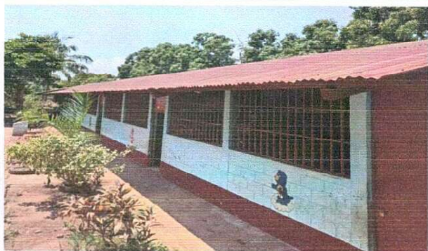
Foto 1: Se observa el mal estado de las laminas por la oxidación y picadura que provoca filtración de agua
