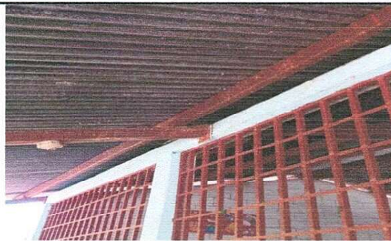
Foto 2: Se observa que la estructura de soporte de lamina necesita su resane para evitar la corrosión.
