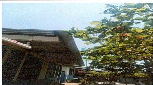
Foto 11: Se observa la falta de canales de metal para la captación del agua pluvial
