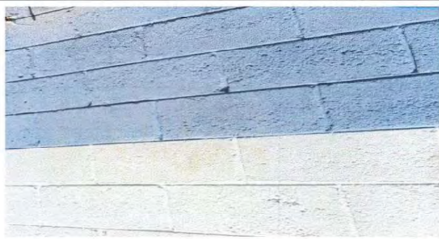
Foto 5: Se observa que el muro esta dañado por la humedad, se requiere colocar azulejo para su protección
