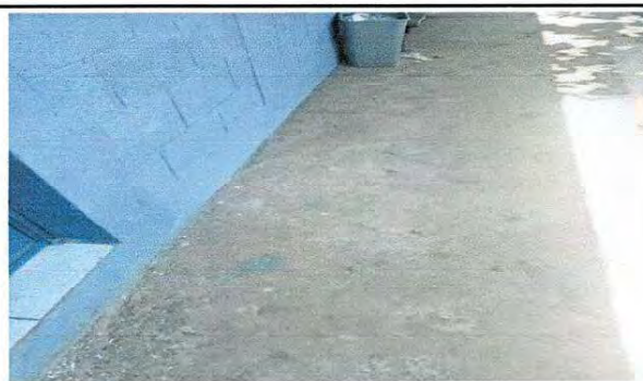
Foto 12: Se observa que el corredor no cuenta con piso antideslizante.
