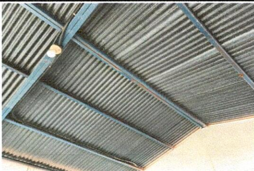
Foto 1: Se observa que la estructura de soporte de metal inicia a deteriorarse por lo que se le deberá brindar mantenimiento.
