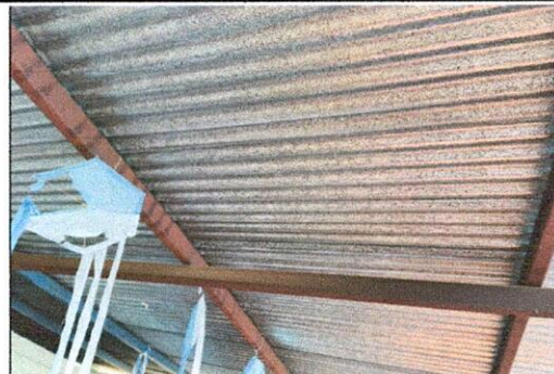
Foto 2: Se observa que la estructura de soporte de metal se encuentra oxidada y deteriorada por lo que deberá de sustituirse.
