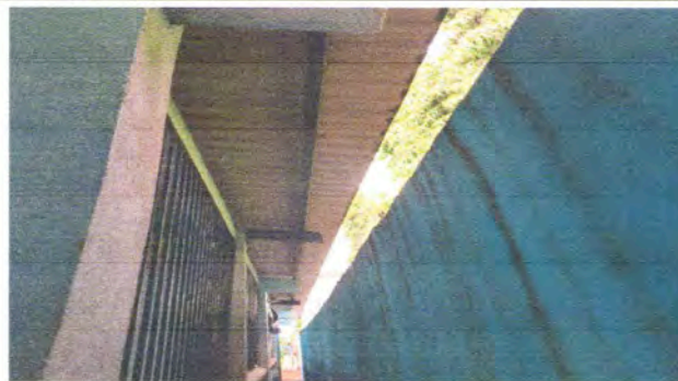
Foto 6: Se observa que estas estructuras no cuentan con canal para la bajada de agua pluvial
