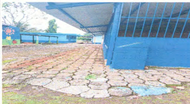
Foto 2: Reparación de piso de torta.
