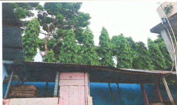
Foto 10 : Sustitución de lámina por lámina troquelada.
