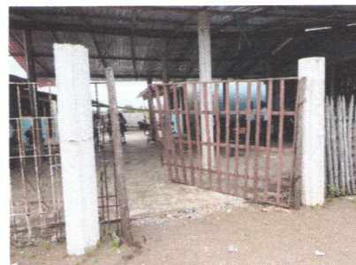
Foto 4: Se observa la necesidad de cambiar el portón con una medida de 3.50 mts de ancho por 2.80 mts de alto.
