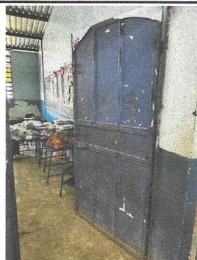
Foto 4: Se observa la necesidad del cambio de la puerta
