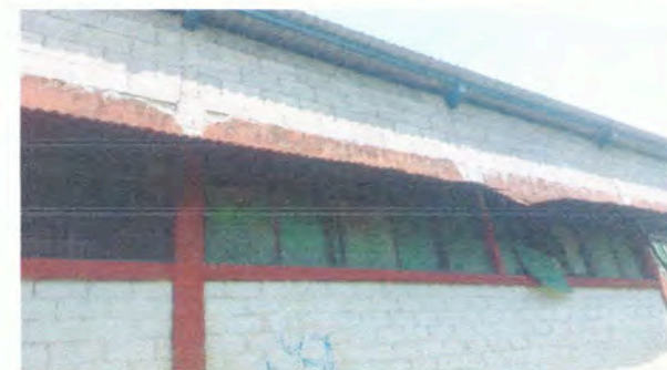
Foto 5: Las vicerias en el modulo 2 protegen de la lluvia pero se pueden ver que estan ya deterioradas..
