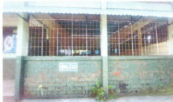
Foto 6: Los balcones en el aula del modulo 2 estan muy deteriorados es necesario el cambio.
