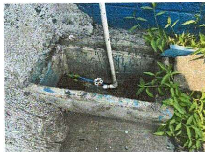
Foto 12: Se observa que la caja de concreto del contador no cuenta con tapadera, por lo que se requiere sustituirla.
