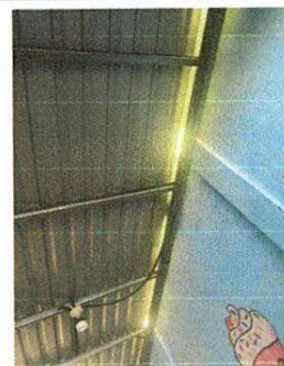
Foto 6: Se observa que es necesario proteger el aula de filtración de agua por lo que se necesita sustitución de lamina por el deterioro de la misma y el sellado de la abertura visible.
