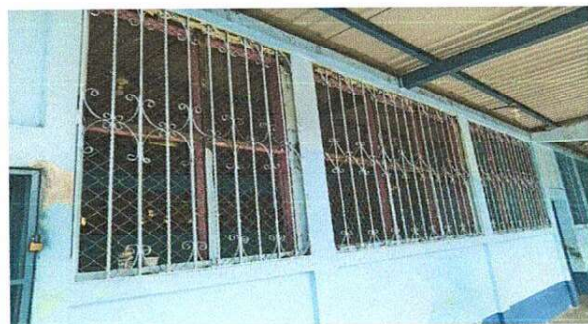
Foto 5: Se observa que las ventanas son de madera con malla, por lo que se necesitan ventanas de pvc + vidrio para poder proteger el aula debido a que es afectada por la lluvia
