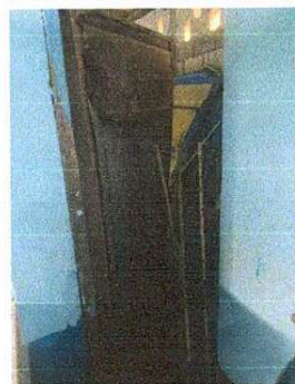
Foto 4: Se observa el mal estado de la puerta por lo que es necesario sustituir.
