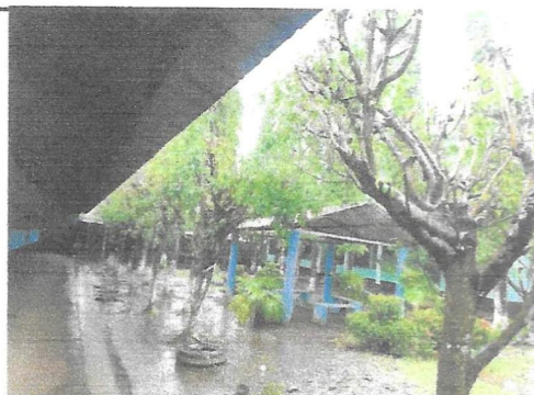
Foto 6: Se puede observar que no hay canal, en epoca de lluvias fuertes, el área del pasillo se llena de agua, lo que puede ocasionar un accidente.
