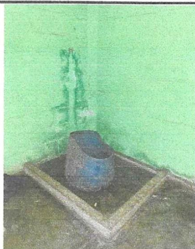
Foto 9: Se observa que el área del baño es suficiente para poder agregar un baño, se requiere adecuar las tuberías de agua y drenaje. Actualmente solamente se cuenta con uno.
