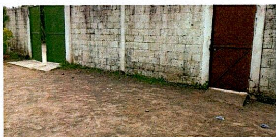
Foto 2.12: En esta área no existe tubería y es necesaria para suministrar servicio de agua en la pila a instalar por lo que se requiere suministro de tubería lineal.
