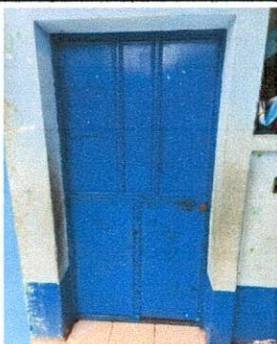
Foto 11: Se observa el inicio del deterioro y oxidación de la puerta del módulo 2 por lo que deberá recibir mantenimiento.
