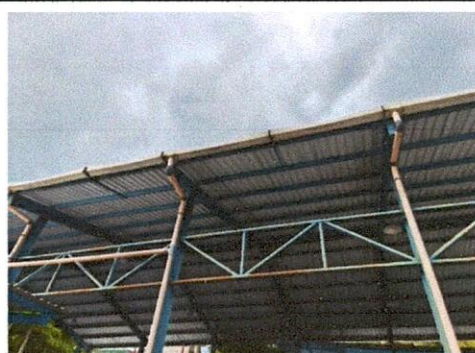
Foto 12: Se observa que los canales en el área de la cancha techada se encuentran doblados y rotos por lo que deberán ser sustituidos.
