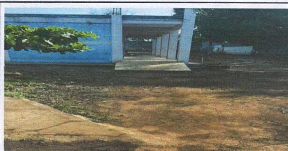
Foto 5: AREA DE ENCAMINAMIENTO QUE COMUNICA EL PRIMER MODULO CON EL SEGUNDO MODULO
