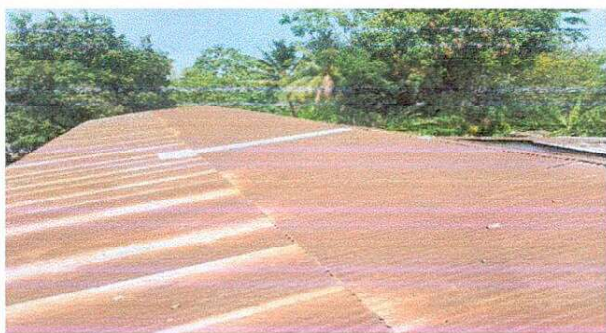
Foto 1: Se observa el mal estado de la lámina en las aulas
