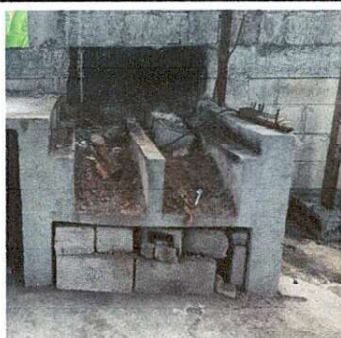
Foto 5: Se observa que la estufa rural esta dañada y no puede ser utilizada, por lo que necesita ser reemplazada.
