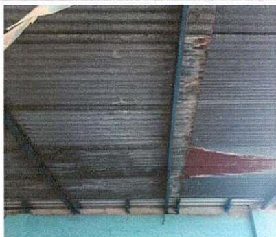
Foto 1: Se observa el mal estado de la lámina, es necesario su sustitución.
