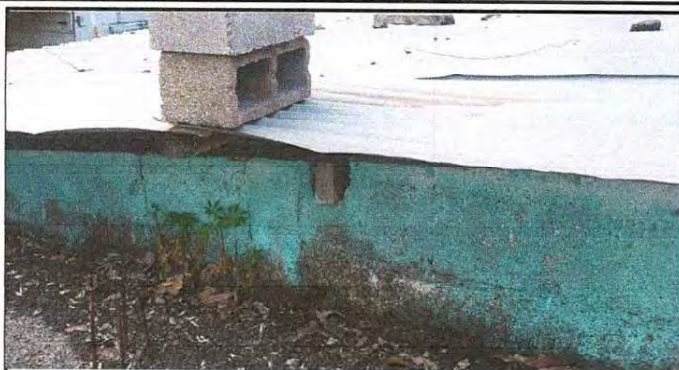
Foto 1: Se observa el mal estado de la lámina en el aula 1
