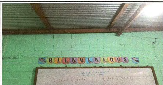
Foto 11: Se observa la necesidad de la prolongación de pared para la conformación de mojinete en el aula.
