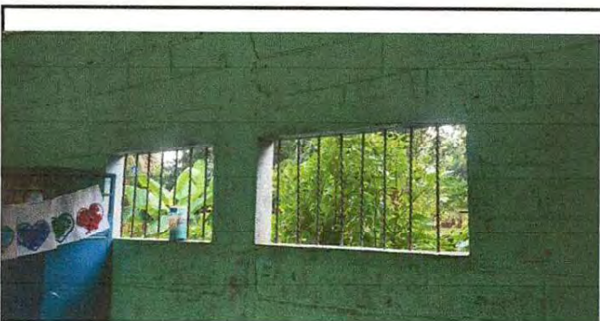
Foto 5: Se observa la falta de ventanería en el aula, por lo que se suministrara ventana de PVC + vidrio.
