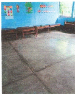
Foto 1: Se observa el piso al que se le instalará piso cerámico.
