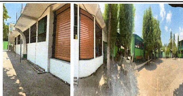
Foto 6: Se observa el área que se pintará fuera y dentro de las instalaciones del centro educativo.
