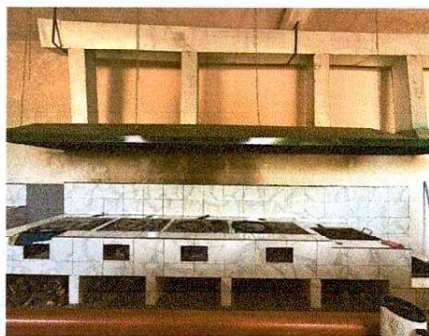
Foto 3: Se observa el área en donde se suministrará el azulejo en el área de cocina.
