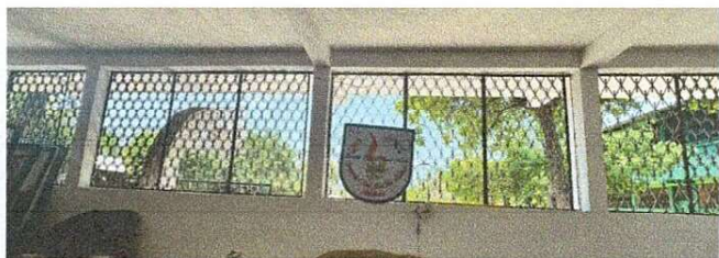
Foto 9: Se observa el área en donde se instalarán las ventanas de pvc.
