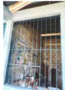
Foto 4. Suministrara e instalación de ventana de PVC + vidrio
