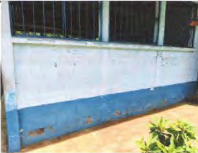
foto 5. se necesita pintado de muros ya la pintura existente esta deteriorada
