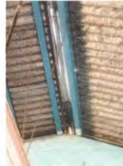
Foto 2: Se observa la estructura de metal del techo a la que se le dará mantenimiento.
