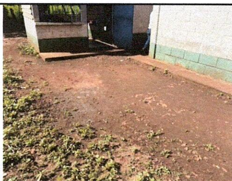
Foto 5: Es necesario una plancha de concreto que conecte las aulas con la cocina.
