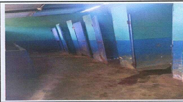
Foto 6: Se observa que en el piso de los sanitarios no existe una reposadera de aguas negras para evacuar el agua cuando es necesario lavar el piso, es necesario colocar una
