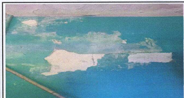
Foto 3: Se observa el deterioro de la pintura en las paredes, es necesario aplicar pintura para cubrir la pared
