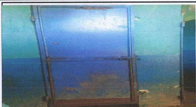
Foto 1: Se observa el deterioro de las puertas de los servicios sanitarios, necesita mantenimiento preventivo y correctivo
