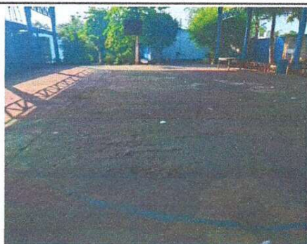
Foto 1: Se observa que la cancha de baloncesto se encuentra en mal estado
