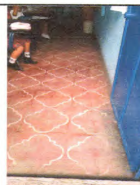
Foto 6: Sustitución piso ceramico en aula
