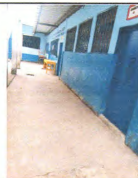
Foto 5: Se hara mantenimiento de pintura a la escuela.
