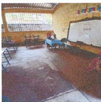
Foto 1: Se observa el piso de un módulo, este es de concreto y se va a sustituir por piso cerámico.
