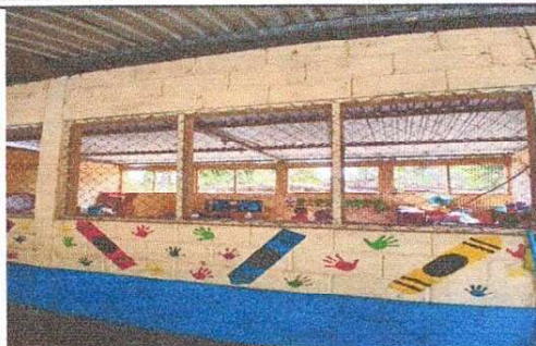
Foto 2: Se Observa el modulo al que se le hara el cambio de malla por balcones de metal.
