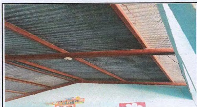
Foto 3: Se observa que la necesidad de energía eléctrica.
