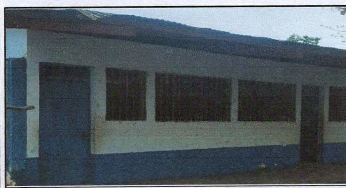
Foto 5: se observa la necesidad de mantenimiento de las puertas de metal
