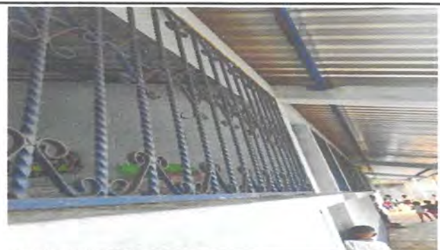
Foto 10: Mantenimiento a Balcones de metal.
