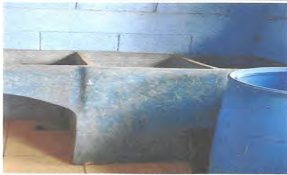
Foto 7: Suministro instalación de Tubería de línea principal hacia la pila, de la cocina ya que no contamos con chorro ni agua en ella.
