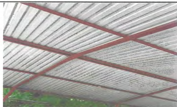
Foto 12: Sustitución de estructura de soporte de metal por metal.
