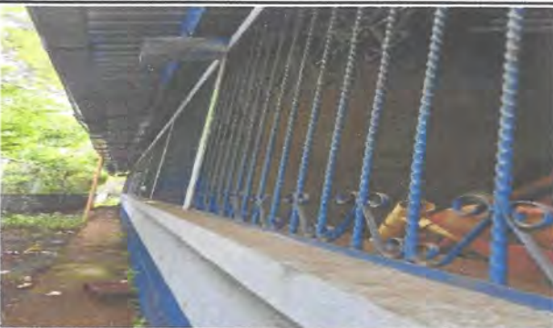
Foto 9: Mantenimiento a Balcones de metal. Para que no se deterioren
