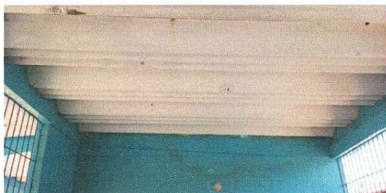
Foto 3: Se observa que no se cuenta con viga de mojinete adecuada para la instalación de la lámina troquelada.
