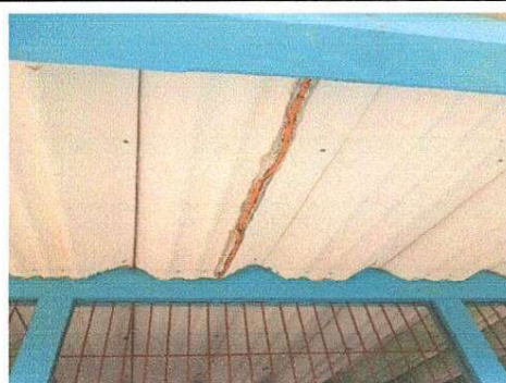
Foto 2: Se observa que no se cuenta con estructura de soporte para la instalación de la lámina, por lo que se debe suministrar
