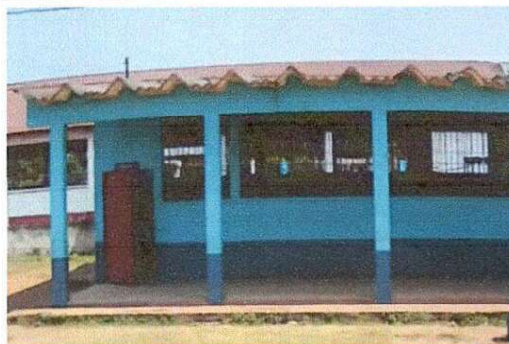
Foto 4: Se observa que será necesario tallar el mojinete para la instalación de vigas.
