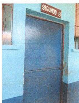
Foto 5: Se observa la puerta metálica en mal estado, por lo que debe cambiarse.
