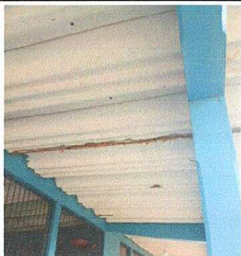
Foto 1: Se observa el mal estado de la lámina en las aulas, por lo que se sustituirán por lámina troquelada Aluzinc calibre 26
