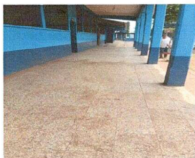
Foto 6: Se observa mosaico en mal estado, debido a los 50 años de uso.
