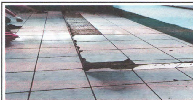
FOTO 5: Reparación ó sustitución de piso cerámico
