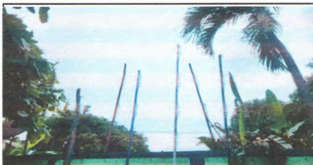
FOTO 6 : Reparación de serca perimetral malla galvanizada
