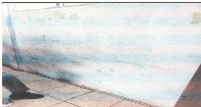
FOTO 9 : Aplicacon de pintura acrilica de primera calidad ( antihongos ) en muro
