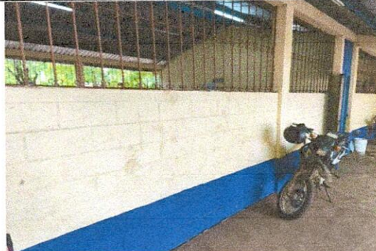
Foto 6: Se observa el desgaste y daño en la pintura por lo que deberá aplicarse nueva.
