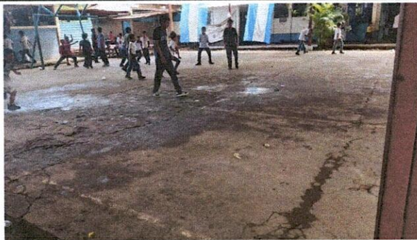
Foto 11: Se observa que las planchas de concreto de cancha se encuentran deterioradas.
