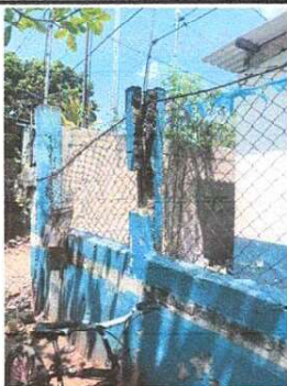
Foto 1: Se observa que el muro perimetral, cuenta con fisuras en mortero, y columnas en mal estado, junto con la malla
