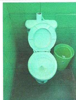
Foto 6: Se observa que el inodoro se encuentra en mal estado, cuenta con rajaduras en la parte de abajo por motivo que se intento instalar anteriormente agua potable
