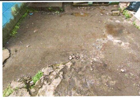
Foto 6: Se observa que se producen encharcamientos y lodo en el área frente al servicio sanitario ya que no cuenta con plancha de concreto.
