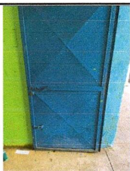
Foto 17: Se observa el inicio del deterioro y oxidación de las puertas del módulo 2.
