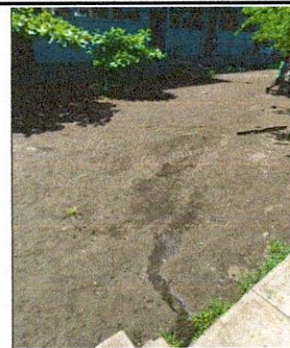
Foto 10: Se observa que no se cuenta con línea principal de agua pluvial, por lo que la escorrentía afecta el patio.
