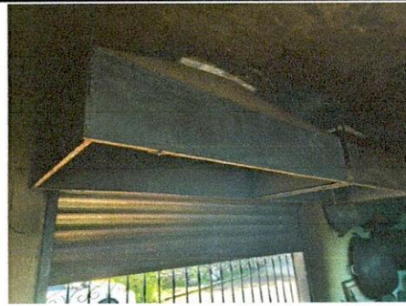
Foto 12: Se observa daño y oxido en los extractores de campana por lo que deberán ser sustituidos.
