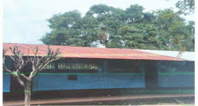
Foto 2: Se observa la necesidad de cambio de lamina de techo
