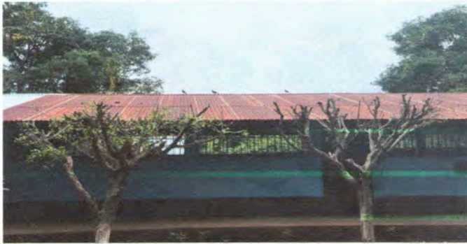
Foto 1: Se observa la necesidad de cambio de lamina de techo
