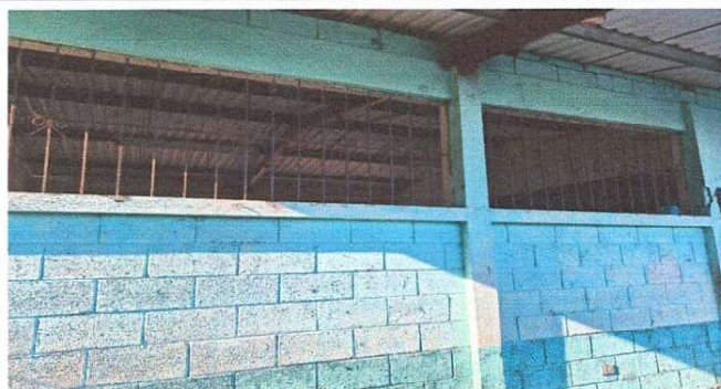
Foto 4: Se observa el deterioro de los balcones, se nota la corrosión del mismo, es meritorio cambiarlos.
