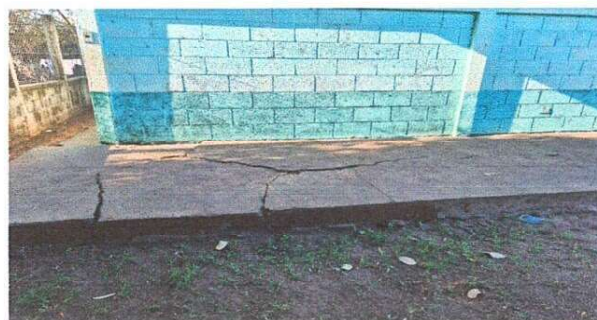
Foto 6: Se puede observar que la banqueta ha sufrido daños por lo cual necesita ser reparada
