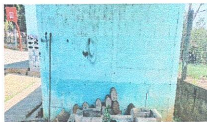
Foto 8: Se observa que la cocina no cuenta con repello, por lo que se le aplicara tanto por fuera como por dentro. A su vez se observa que sobre esta aplicacion de repello se pintara la cocina por dentro y por fuera.
