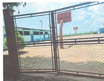
Foto 12: Se observa que el porton es de malla y no brinda suficiente proteccion. Debe ser reemplazado por un proton nuevo de lamina metalica.
