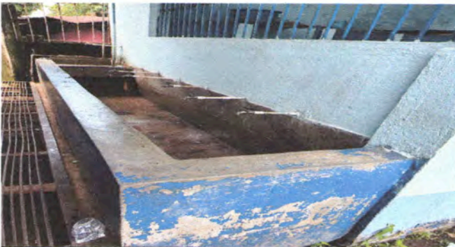
Foto 5: Por el tiempo y el uso la estación de lavados luce deteriorado por lo que se solicita la sustitución del azulejo.
