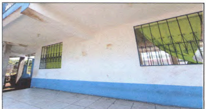
Foto 6: Algunos muros del módulo 2 no tienen pintura y otros están des pintados por lo que se solicita la aplicación de pintura en muros exteriores.
