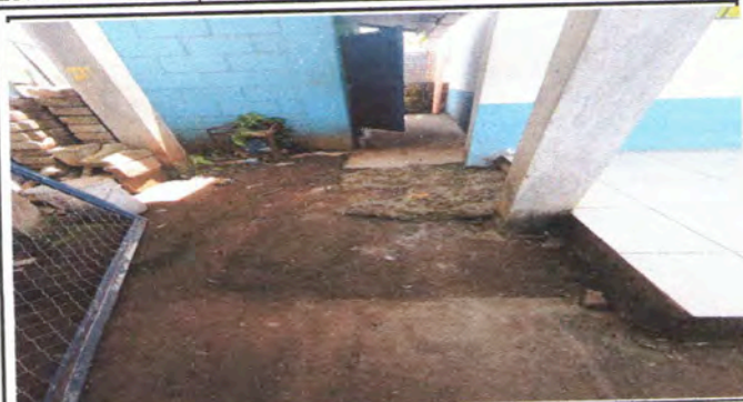
Foto 13: Para el cambio de letrinas a baño labables se necesita de suministro e instalación de tubería PVC línea principal aguas negras.
