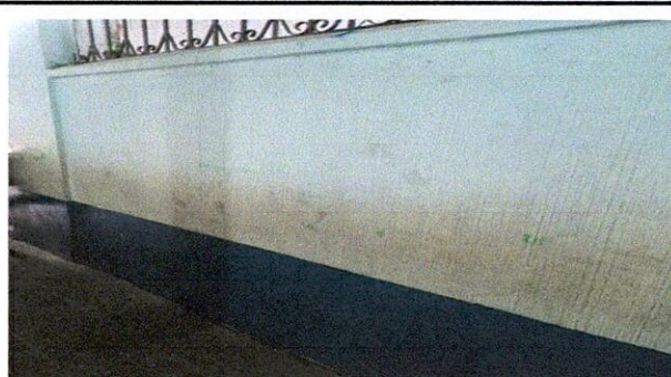
Foto 6: Aplicación de pintura, necesaria por motivo de estar muy manchadas las paredes.
