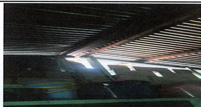
Foto 9: Mantenimiento de la estructura de soporte.
