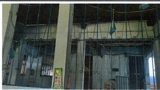
Foto 4: Instalación de ventana de pvc mas vidrio por motivo que las actuales se encuentran en mal estado.
