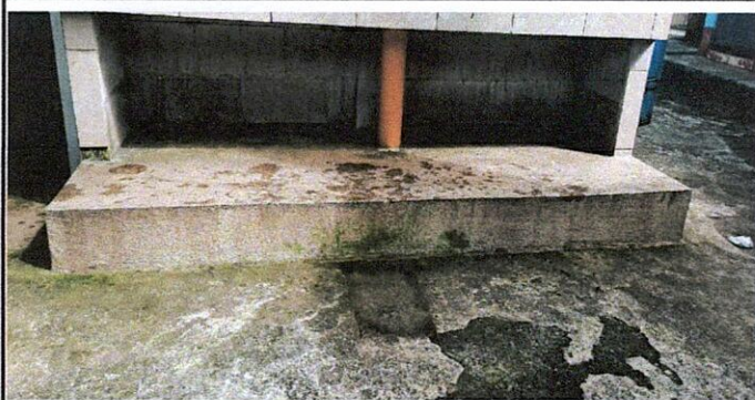
Foto 15: Suministro de banqueta de concreto en los lavamanos. Y piso cerámico antideslizante.
