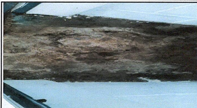
Foto 13: Cambio de piso por piso cerámico.
