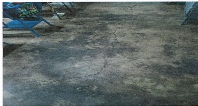
Foto 14: Sustitución de piso, por piso cerámico.
