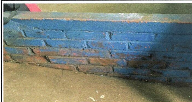
Foto 23: Alisado de muro por grietas.
