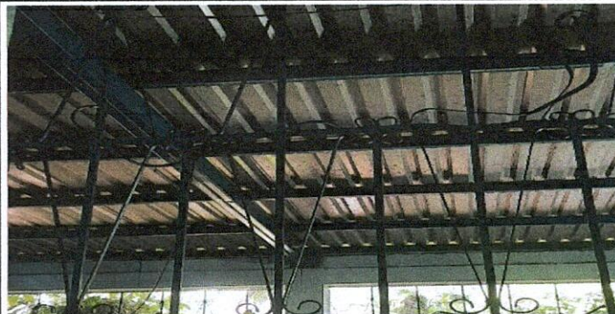
Foto 18: Sustitución de balcones, motivo inservible.
