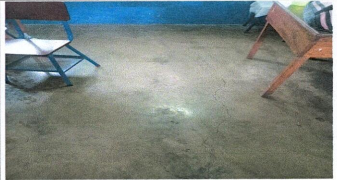
Foto 8: Cambio de piso de cemento por piso cerámico.
