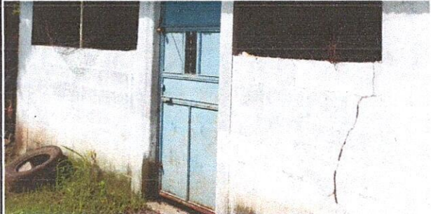
Foto 8: Se aplicara pintura en muros
