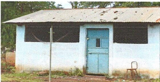
Foto 5: Se trabajara el cernido en los muros
