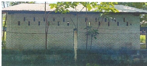
Foto 13: Reparación de muro
