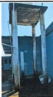
Foto 5: Torre de concreto para el depósito de agua que debe ser sustituido por presentar notable deterioro
