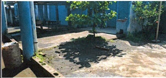
Foto 2: Área propensa a acharcamiento donde se realizará el caminamiento con concreto hidráulico
