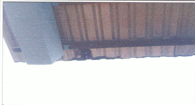
Foto 1: Se observa la necesidad de cambiar la lámina que se encuentra picada
