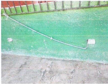
Foto 7: Se observa que no se cuenta con el sistema eléctrico en buenas condiciones, debe ser sustituido he introducir el cableado en los muros.
