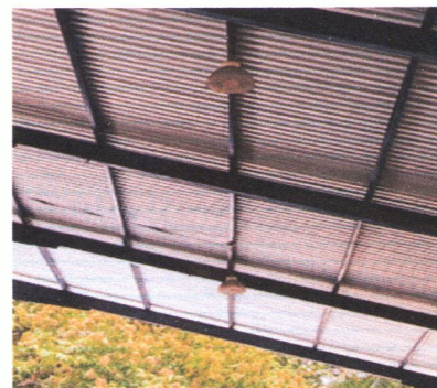
Foto 8: Se observa la polideportiva a la que se le instalará el sistema eléctrico.
