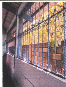
Foto 4: Se observa el area donde se instalarán las ventanas de vidrio y PVC.
