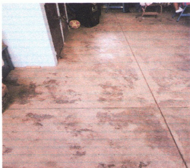
Foto 1: Se observa el area donde se instalará piso ceramico.
