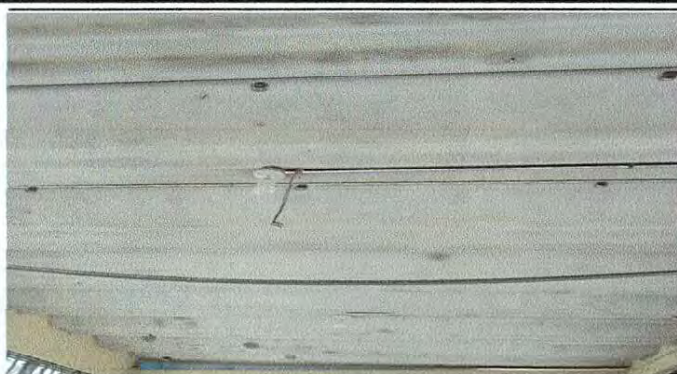
Foto 2: Se observa la falta de costaneras
