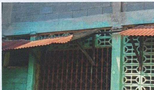
Foto 3: Se observa estructura de madera y en mal estado
