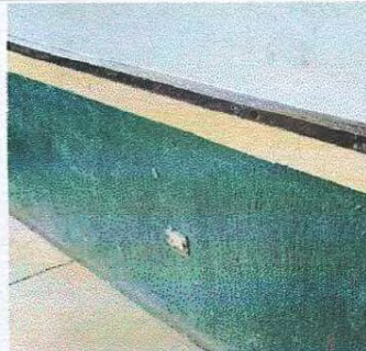
Foto 6: Podemos observar que en las aulas seleccionadas no cuentan con dispositivos electricos en buen estado
