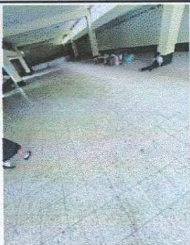
Foto 1: Podemos obser que el piso de granito no esta pulido ni lustrado
