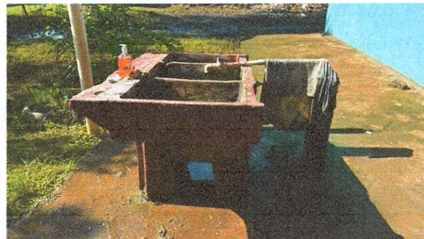
Foto 8: Se observa que la pila se encuentra deteriorada, y se cambiara de lugar ya que está al frente de las aulas.
