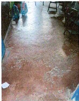
Foto 3: Se observa el deterioro del piso de concreto, se requiere colocar piso cerámico.
