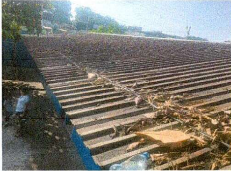
Foto 1: Se observa el mal estado de la lámina, para lo cual se requiere sustitución
