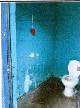
Foto 5: Se observa el piso y las paredes de los baños, se requiere colocar piso cerámico y azulejo.
