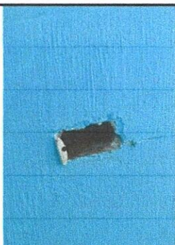
Foto 3: Se observa el estado en el que se encuentra el sistema eléctrico en dirección.
