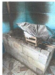
Foto 10: Se determina la necesidad de la sustitución de la estufa.
